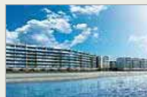
太陽熱供給システムを導入した集合住宅の整備
