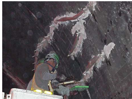
ひび割れ注入による補修
