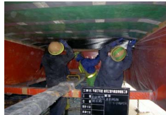
炭素繊維シートによる補修
