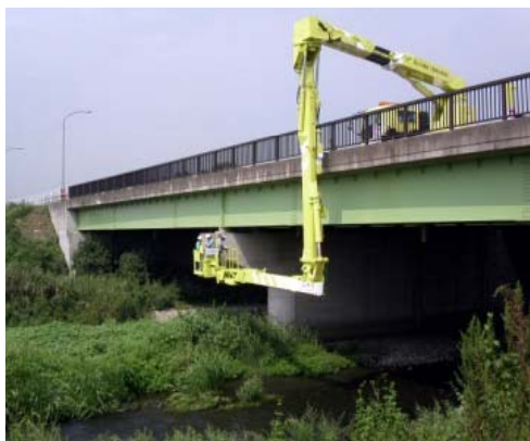
橋梁点検車を使った 橋梁点検
