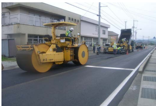
切削オーバーレイによる補修
