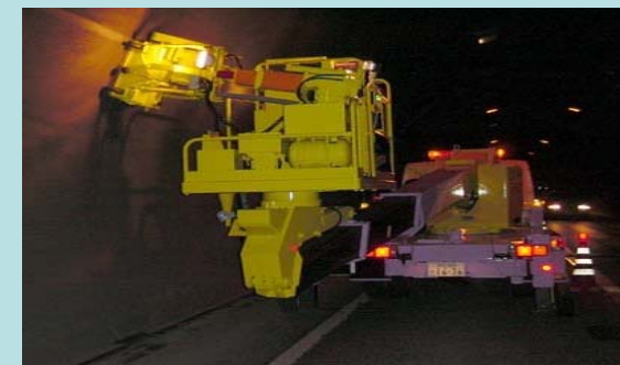
【検査車による非破壊検査】
