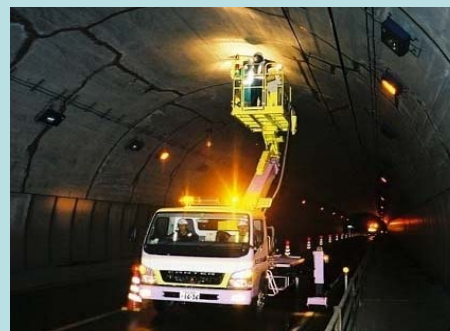
【近接目視によるひび割れ探査】
