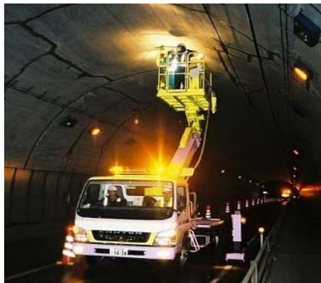
近接目視による ひび割れ探查
