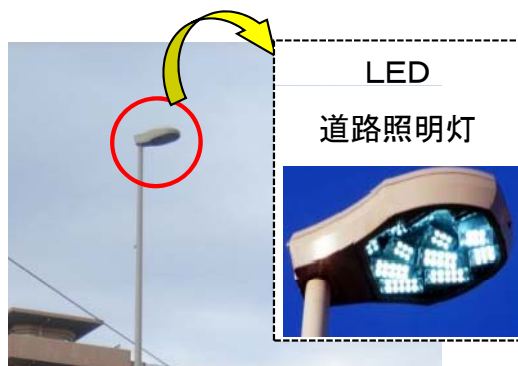
LED道路照明灯の整備
