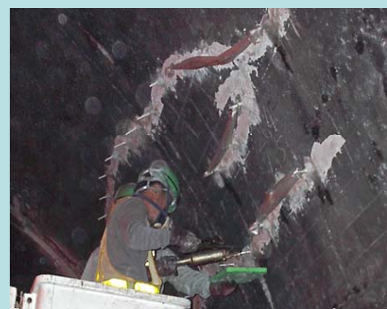
【クラック注入によるひび割れ補修】
