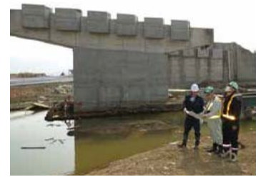
津波により流出した橋の調査
