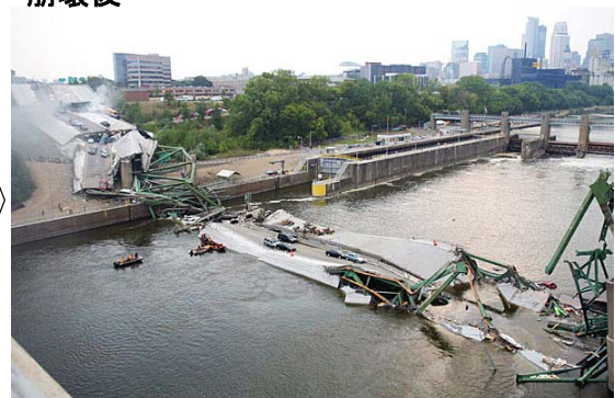
図 2-4 ミネアポリス I-35W 橋の崩壊事故
