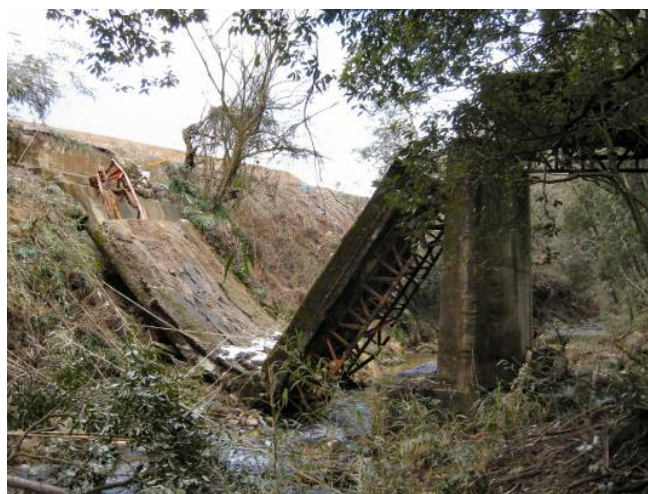
図 3-2 管理者不明橋梁の崩壊事故(平成 19 年)
