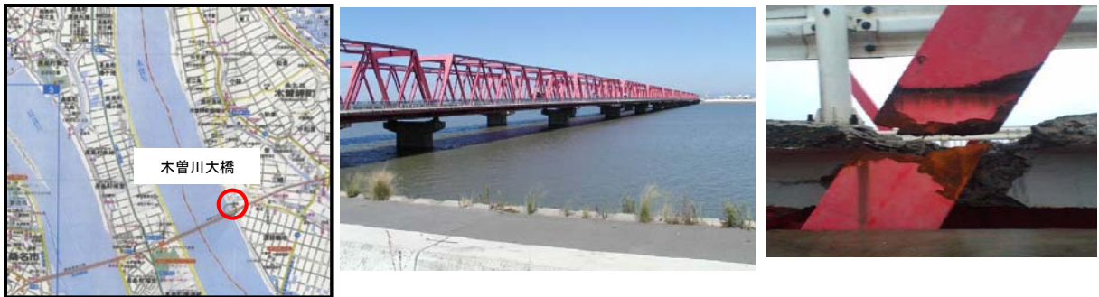
図 2-3 木曾川大橋のトラス斜材の破断事故
