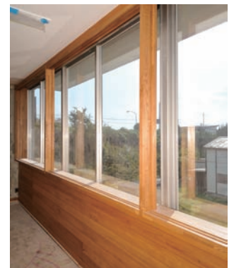
既存庁舎内側の窓枠にも木材を使用。雰囲気と共に機能面も考慮している。
