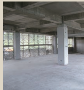
既存庁舎は、骨組みなど躯体のみの状態にした上で、工事に取りかかった。
