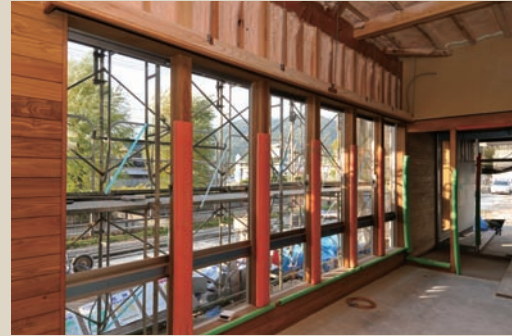
増築庁舎にあるエントランスは一般の方も利用されるため、木造化と共に、採光部を大きくし、明るい開放的な印象にリニューアル。
