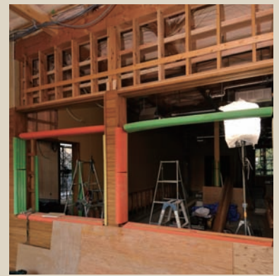
エントランスと事務室を隔てる内窓。内部の補強と共に、表面も木材を使用。
