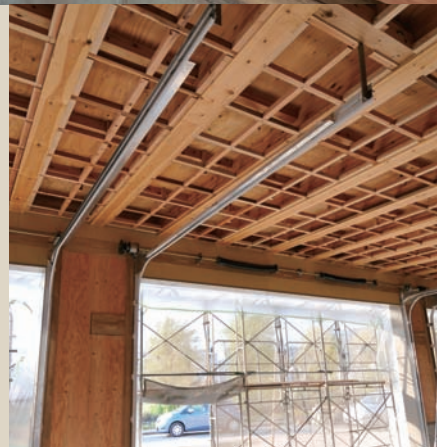
上段／車庫の屋根を支える柱・梁には、強度の高い岡山県産の欧州赤松を使用。右／木材に取り付けた車庫シャッター用の金属製レール。下段／接合部の正確さを確認するため、事前に製作した原寸サンプル。
