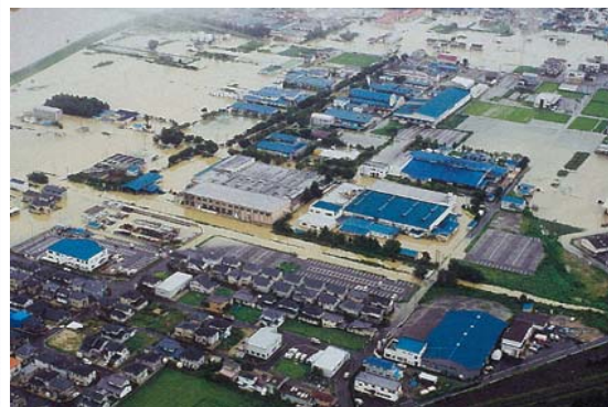
サプライチェーンを寸断しかねない工業団地の浸水状況
