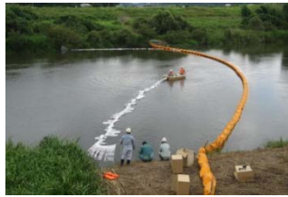
オイルフェンスの設置による被害拡大防止 (平成24年大分川水系大分川油漏れ(灯油流出)事故)
