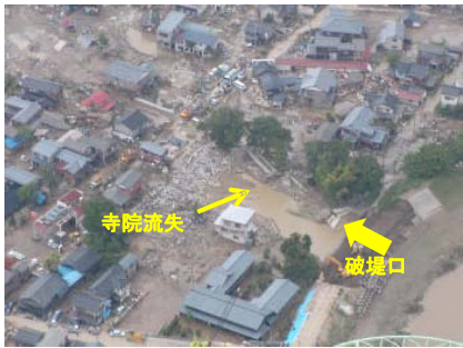
堤防決壊時の甚大なエネルギーにより26戸の家屋等が流失
