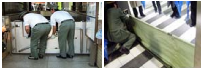
自主的な防災訓練での止水版設置 (H23年5月)
