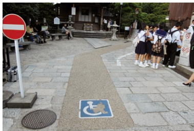
車いす用舗装部
