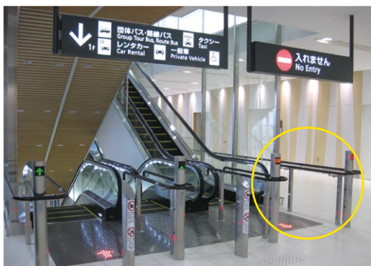
逆進入防止装置 (囲み部分)
