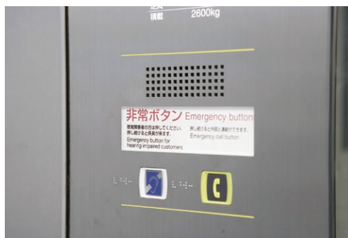
聴覚障害者専用の非常ボタンを設置したエレベーター (非常ボタン写真)
