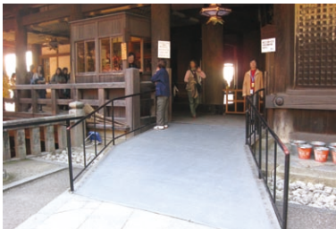
本堂横のスロープ
