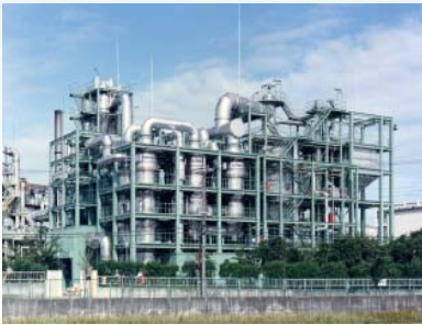
下水汚泥 焼却プラント
