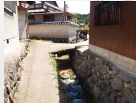
1 民宿花井付近 側溝
