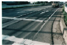
(舗装のわだち掘れ)
