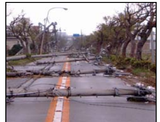
(台風による道路の被災状況)
