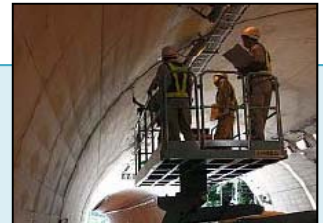
(道路構造物の点検)
