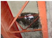
(橋梁の抜け落ち)
