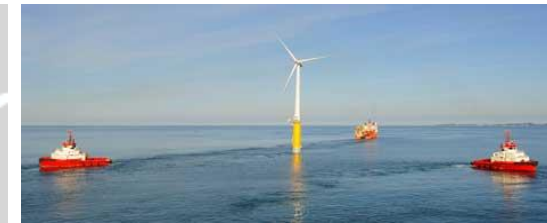
設置水域に曳航されるHywind
