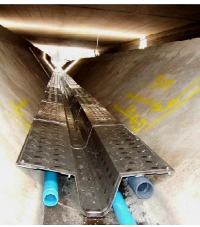
雨水越流槽に設置されている熱交換器
