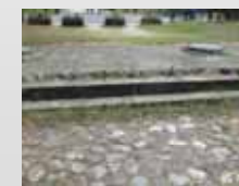
13 川原寺前 足下・段差
