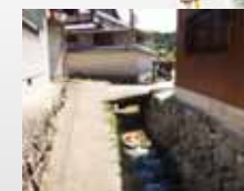
1 民宿花井付近 側溝
