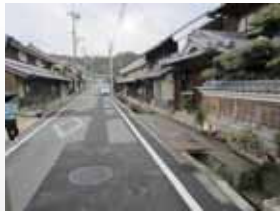
明日香村地区の集落内の道路 地区内の道路は幅員が狭く、狭隘区間も多い。 歩道の側溝に蓋かけのない道路も多い。
