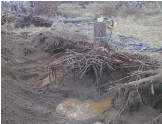
1.2m 程掘削すると地下水位が現れる。
