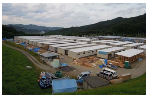
仮設住宅用地(釜石市 平田総合公園)
