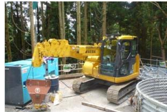
クローラクレーン
