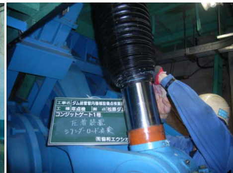
ダム用ゲート点検 (開閉装置)
