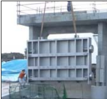
新設のステンレス水門
