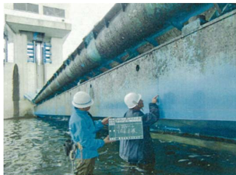
河川用ゲート点検 (扉体)
