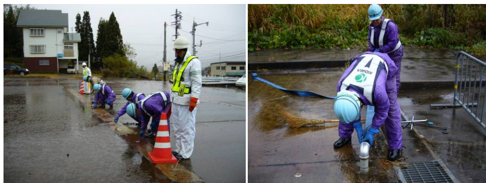
消雪パイプ点検状況
