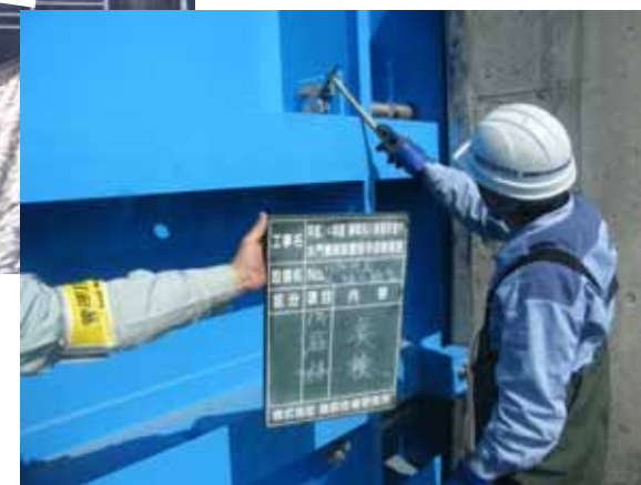
扉体点検状況
