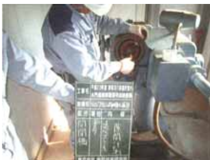
河川管理施設の修繕
