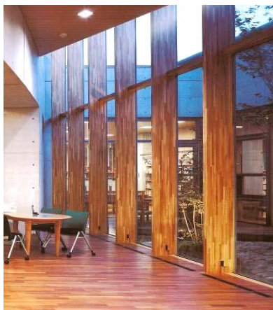
木製カーテンウォール 田原市中央図書館
