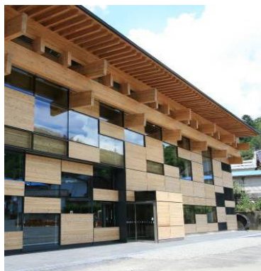
木製パネル 梶原総合庁舎
