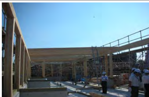
車庫棟：柱・梁の施工状況
