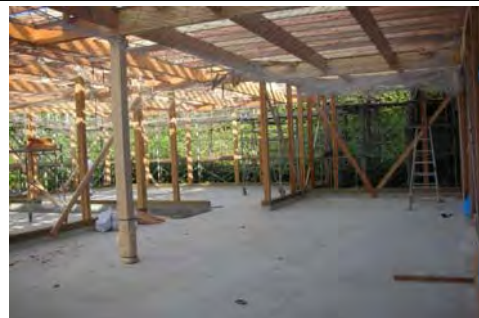
庁舎棟：柱・梁の施工状況
