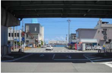
臨港線跡遊歩道が不連続のため、来訪者等歩行者の横断が危険である(江尻漁港)
