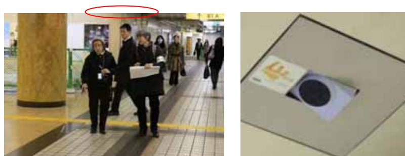
図 6-7 屋内の天井に設置された赤外線マーカ
