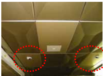
同一の場所に複数の赤外線マーカを設置した事例(平成 22 年度銀座地区)
