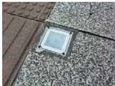
路面に埋め込んだ電波マーカ（左）と植え込みの中に設置した電波マーカ（右）（平成 22 年度銀座地区）
