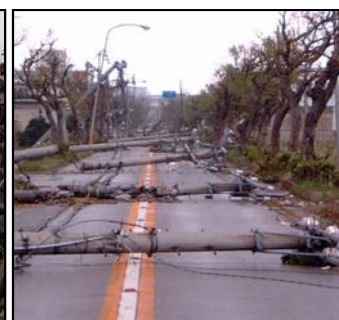
(台風による道路の被災状況)
