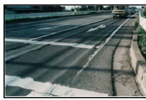
(舗装のわだち掘れ)
