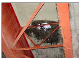
(橋梁の抜け落ち)
