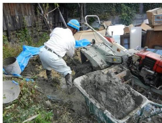
写真 3-9 工事現場でさらに藁を混ぜている様子
