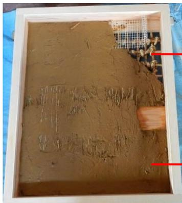
写真 3-1 土壁の構造
