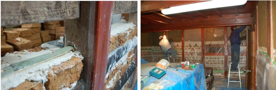
写真 3-23 土ブロックによる施工（写真：輪島土蔵研究会より）
