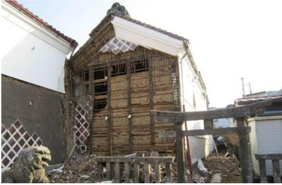
写真 2-13 土壁の被災状況
