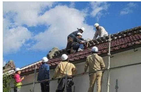
写真 3-29 瓦屋根の実測の様子
