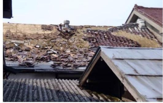
写真 2-14 瓦屋根の被災状況
