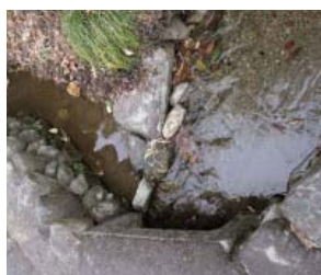
小堰の分水堰
