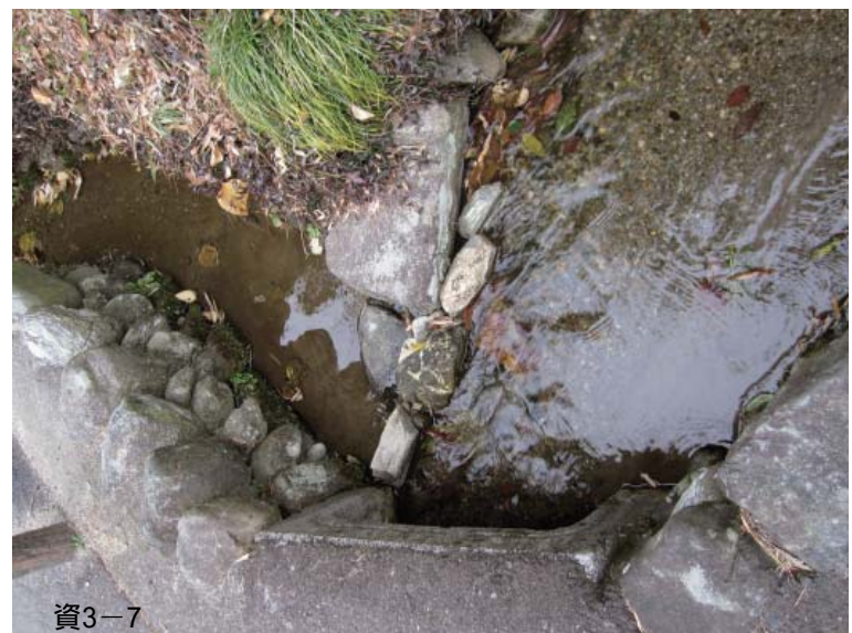
矢羽橋分水路
