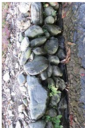
小堰の石積み護岸
