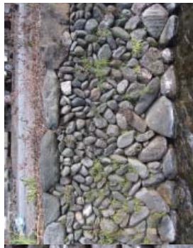
大堰の石積み
