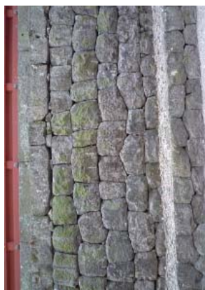
東照宮の間知石による石積み
