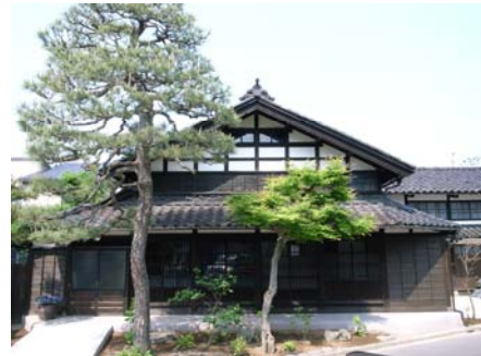
写真 1-3 長町集真藍工房外観
