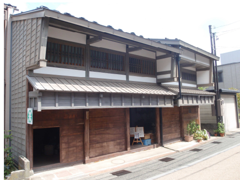
写真 0-1 古い外観意匠を残す町家の事例
