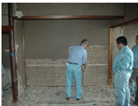
写真 1-12 伝統的構法木造建築物の構造実態調査
