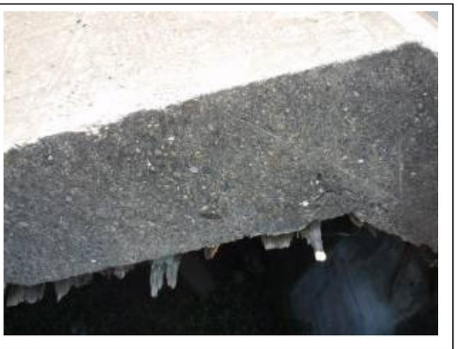
屋根厚 RC45cm。鉄筋がみえる。RC造。
