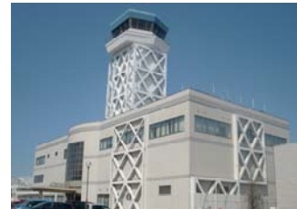
(庁舎・管制塔の倒壊防止)
