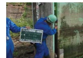
ゲート設備の点検・整備
