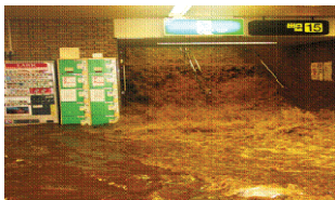
平成15年7月 福岡市営地下鉄博多駅
