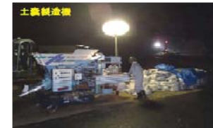
土のう製造機の貸与 H24年九州・北部豪雨
