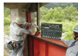
樋管ゲートの点検
