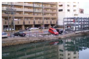
鋼矢板護岸の損壊状況
