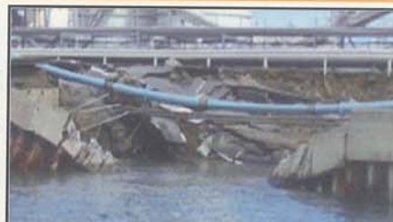
液状化による護岸の被災
