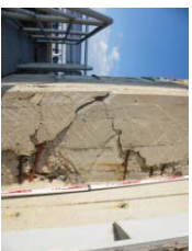
水門の門柱部のコンクリート剥離
