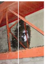
(橋梁の抜け落ち)
