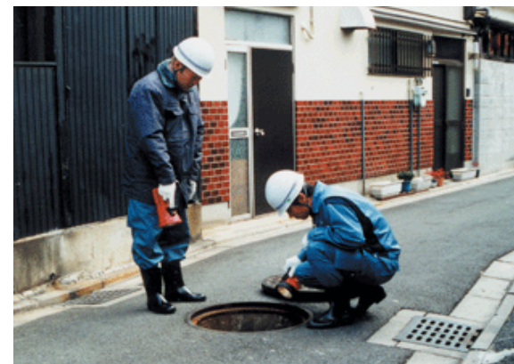
マンホール目視
