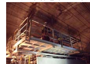
トンネル天井部の点検の様子
