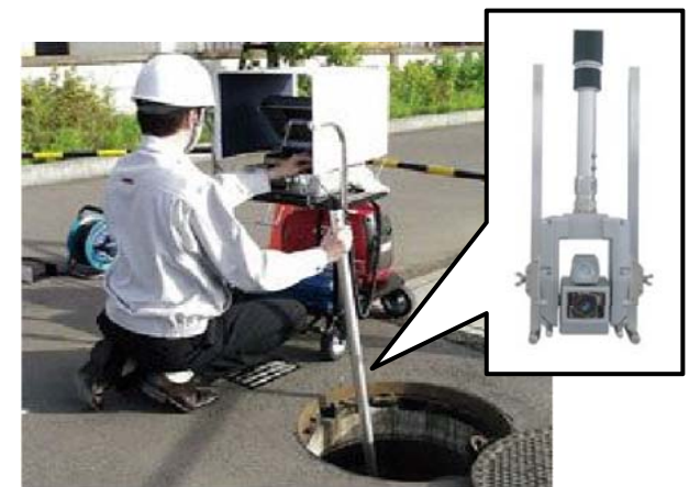
管口カメラ調査
