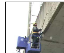
高架橋防音壁の点検の様子
