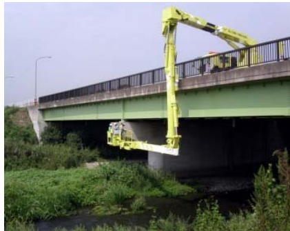
橋梁点検車を使った 橋梁点検
