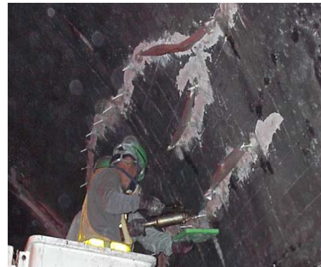
ひび割れ注入による補修
