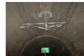
下束(架線を吊る金物)
