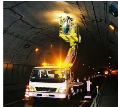
近接目視による トンネル点検
