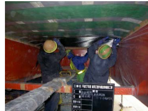
炭素繊維シートによる補修
