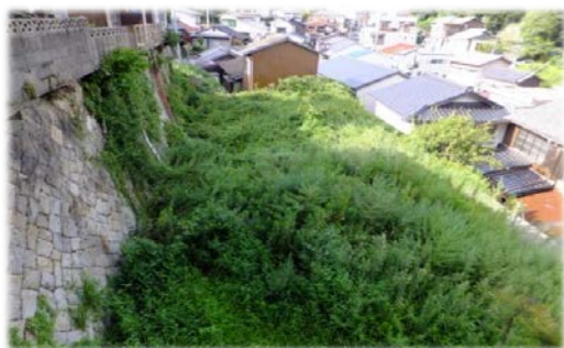
写真1 2 整備前の様子
