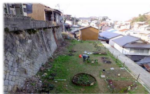
写真1 3 整備後の様子
