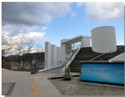
日吉ダムビジターセンター
