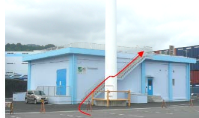
受変電所の屋上を活用
