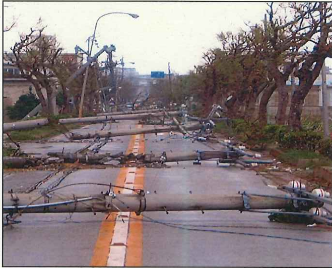
(台風による道路の被災状況)
