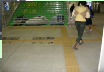
▼構内の視覚障害者誘導用ブロックの設置
