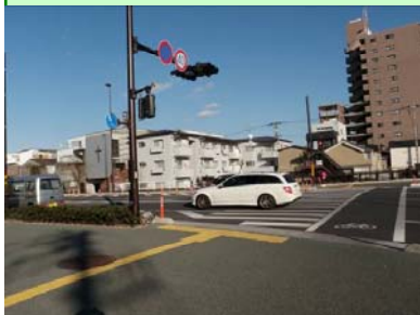
▲視覚障害者誘導用ブロックの連続的な設置と横断歩道部分の段差改良
