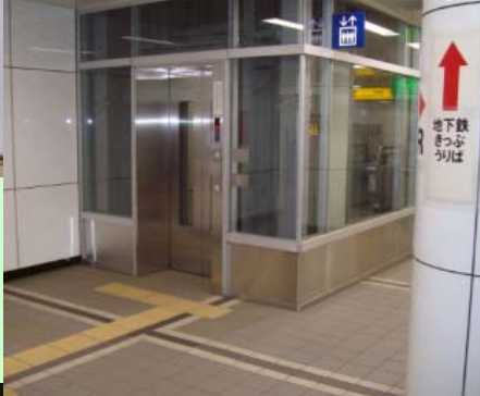
▼ホームから改札階へのエレベーターを設置。(仙台駅)
