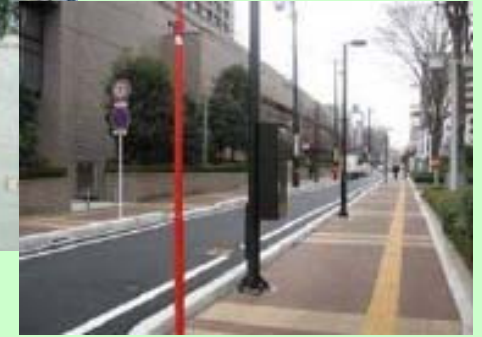
▲▼歩道の整備(視認性のある視覚障害者誘導用ブロックと電柱の地中化)
