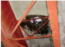
(橋梁の抜け落ち)
