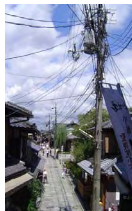
< 美観を損ねる 電柱・電線 >
