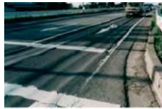
(舗装のわだち掘れ)
