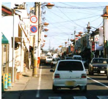
< 歩行の支障となる電柱 >
