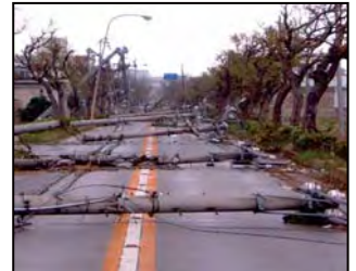
(台風による道路の被災状況)
