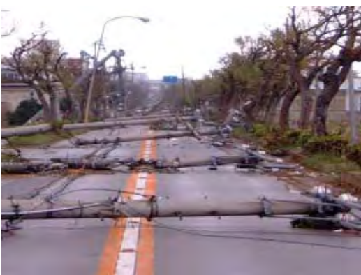
< 電柱の倒壊による道路閉塞 >
