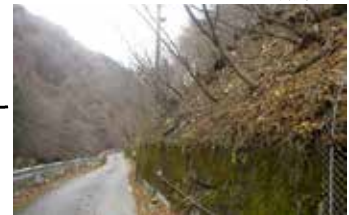
<災害時に崩落の恐れのある箇所>
