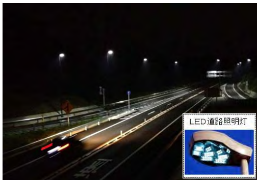
< LED 道路照明灯の整備 > (中国横断自動車道尾道松江線)
