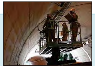
(道路構造物の点検)
