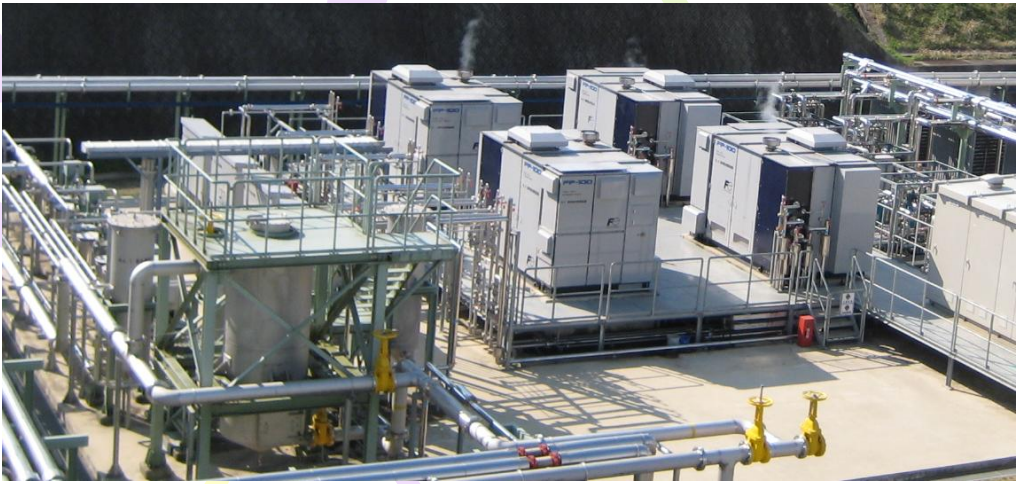
熊本北部浄化センター消化ガス発電設備
