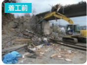
津波により橋脚から落ちた線路を切断しながら撤去。
