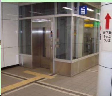
▼ホームから改札階へのエレベーターを設置。(仙台駅)
