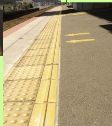
内方線付き点字ブロックの設置▲
