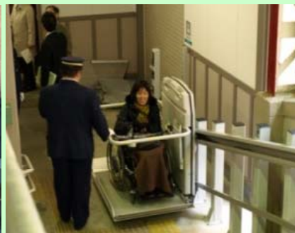
▼▲景観にも配慮したエレベーター等の設置 ▲階段昇降機の設置
