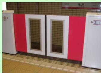
▲仙台市交通局においては全駅に可動式ホーム柵を設置。(仙台駅)
