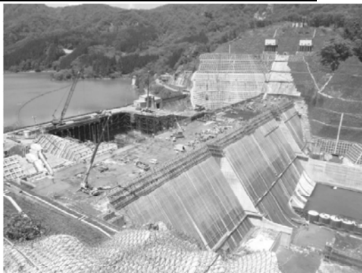
ダム本体の打設状況
