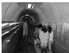
施工中のダム内部を 見られる見学ツアー
