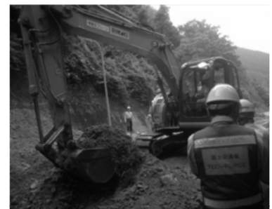
孤立集落解消に向けた土砂撤去【国道315号山谷トンネル坑口付近】
