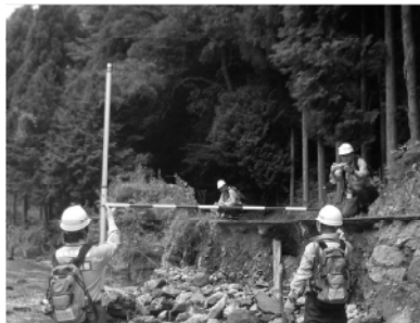
早期の災害復旧にむけた調査【高津川（平成25年8月1日）】
