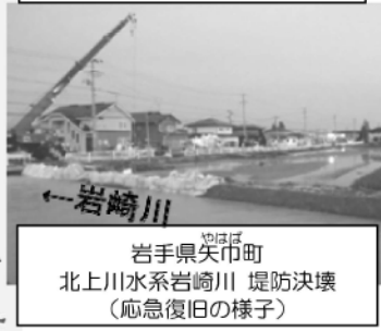
岩手県矢巾町 北上川水系岩崎川 堤防決壊 (応急復旧の様子)
