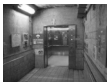
堤体内に設置された エレベータを見学に利用
