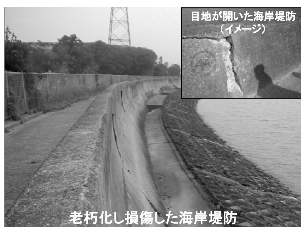
【海岸保全施設の老朽化対策例：尾道系崎港海岸】
