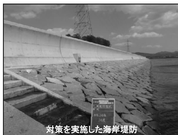
【海岸保全施設の老朽化対策例：尾道系崎港海岸】
