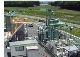
実証プラント
