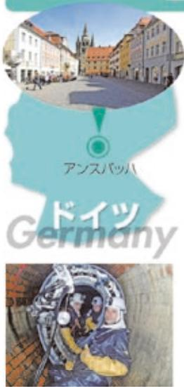
積水化学工業株式会社（以下、積水化学）、東京都下水道サービス株式会社、足立建設工業株式会社の3社は共同開発してきた日本発の管路更生工法「SPR工法」の国際展開を3社連携のもと進めてきました。東京都下水道サービス株式会社が設計マニュアルの作成や相手国政府との関係強化を通じた日系企業の海外展開の牽引を、足立建設工業株式会社が施工機械の開発を、また積水化学が施工材料の開発、製造、施工と事業展開を担っております。本件は、積水化学の子会社 Sekisui SPR Europe 社（在ドイツ）の事例であり同社が「SPR工法」の技術的優位性をアンスパッハ市に訴求し、歴史的建築物を含んだ交通量の多い居住エリアにおける建造後77年経過したレンガ作りの逆卵形の複雑な形状に対応した管路更生技術を提案しました。結果として、同市の管路更生において、歴史的建造物の保全、都市生活の安定化、経済性の確保を実現しました。同様の実績をドイツの例に限らず、フランス、ブルガリア、ポーランド他世界中で展開しています。
