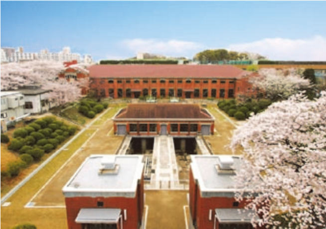
《唧筒場施設 全景》
