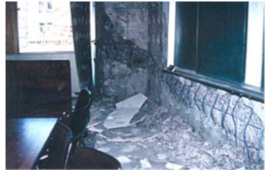
内部の被災状況
