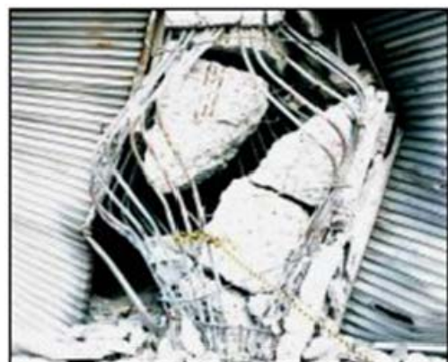
店舗1階柱の圧壊
