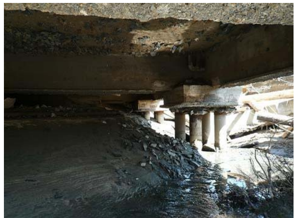
建物基礎が露出
