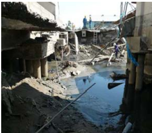
庁舎周囲の地盤流出
