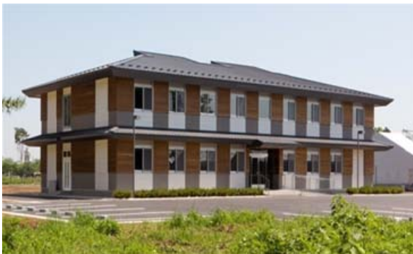
横浜植物防疫所つくば圃場(事務・検査棟)
