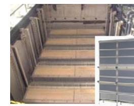
反応タンク内のMF膜(平膜)膜ユニットのユニット MF膜:0.01~10μm
