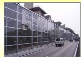
設置後:63dB(夜間)
