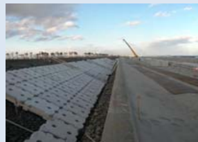
コンクリート二次製品の設置状況
