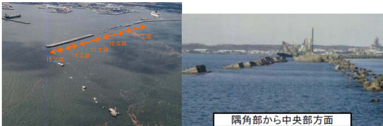
図Ⅱ-2.6(b) 八戸港北防波堤（中央部）の被災状況。北防波堤中央部 11 工区から 15 工区までの被災状況外観（左）と側面から見た被災状況（右）
