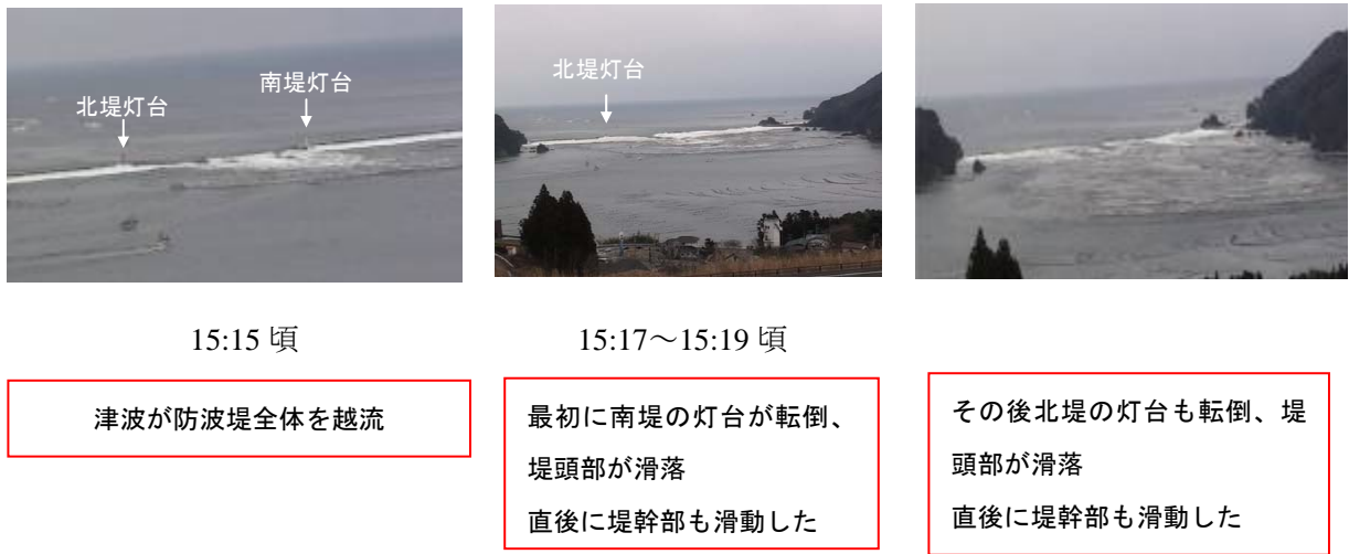
図 II-2.17 大船渡港湾口防波堤における津波来襲時状況
