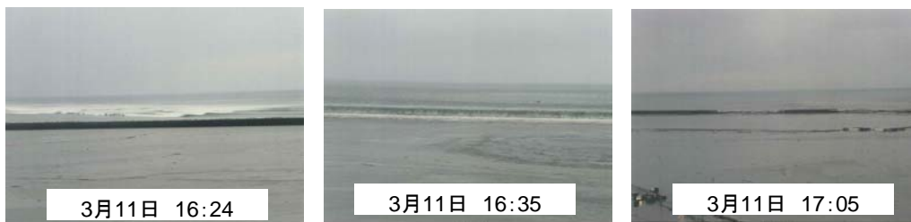
図Ⅱ-2.6(a) 八戸港北防波堤に來襲する津波
