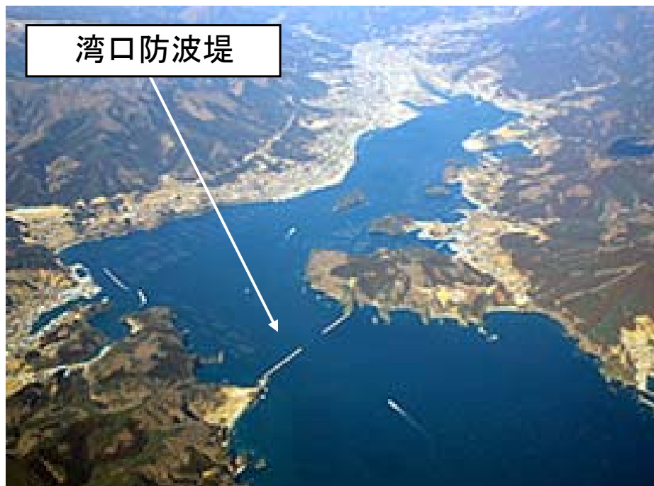
図Ⅱ-2.15 大船渡港湾口防波堤の外観
