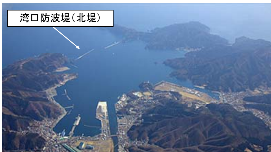
図Ⅱ-2.10 釜石港湾口防波堤の外観
