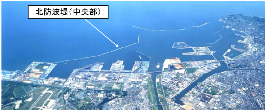
図Ⅱ-2.5 八戸港北防波堤における中央部の位置
