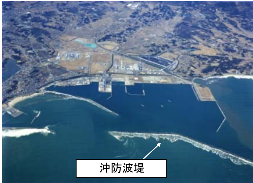
図 II-2.20 相馬港沖防波堤の外観
