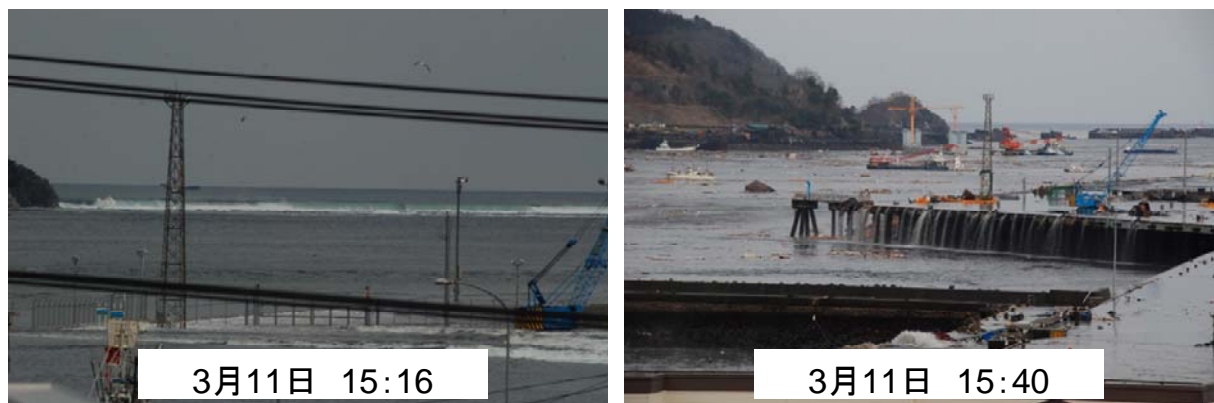
図Ⅱ-2.11 釜石港湾口防波堤における津波来襲時状況
