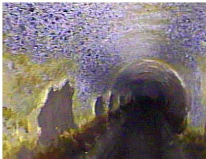
【ランク B】 骨材露出状態(HP、B市事例)
