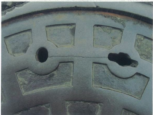
① ふたのクラック (Aランク)
