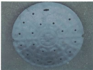
① 残存模様高さ (Aランク)
