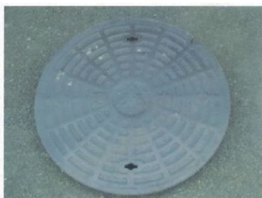
② 残存模様高さ (Aランク)
