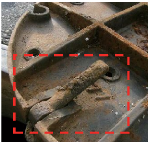
② 腐食に伴う蝶番の破損(Aランク)
