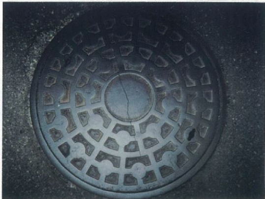
② ふたのクラック (Aランク)
