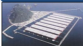
浮体式石油備蓄基地（ベトナム）
